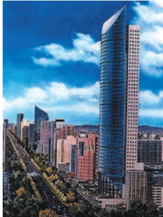
Figura 2. Una visión del futuro cercano. El edificio de la Torre Mayor se construye de acuerdo con los principios señalados en el Paseo de la Reforma de la ciudad de México. El edificio cuenta con 96 amortiguadores y será el más alto de América Latina.
