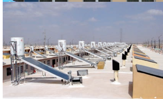
Figura 5. (a) Integración de nuevas tecnologías a la envolvente de edificaciones (arriba y centro); y (b) Utilización de tecnologías de calentamiento solar y de climatización pasiva en un conjunto de viviendas de interés social en Ciudad Juárez, Chihuahua, México (abajo). Cortesía de Sunway, S.A.
