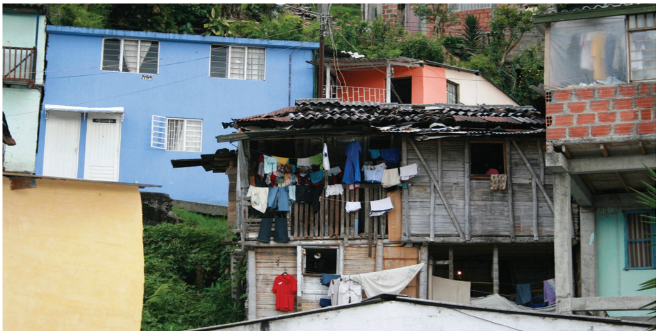
Riesgo en viviendas populares.
