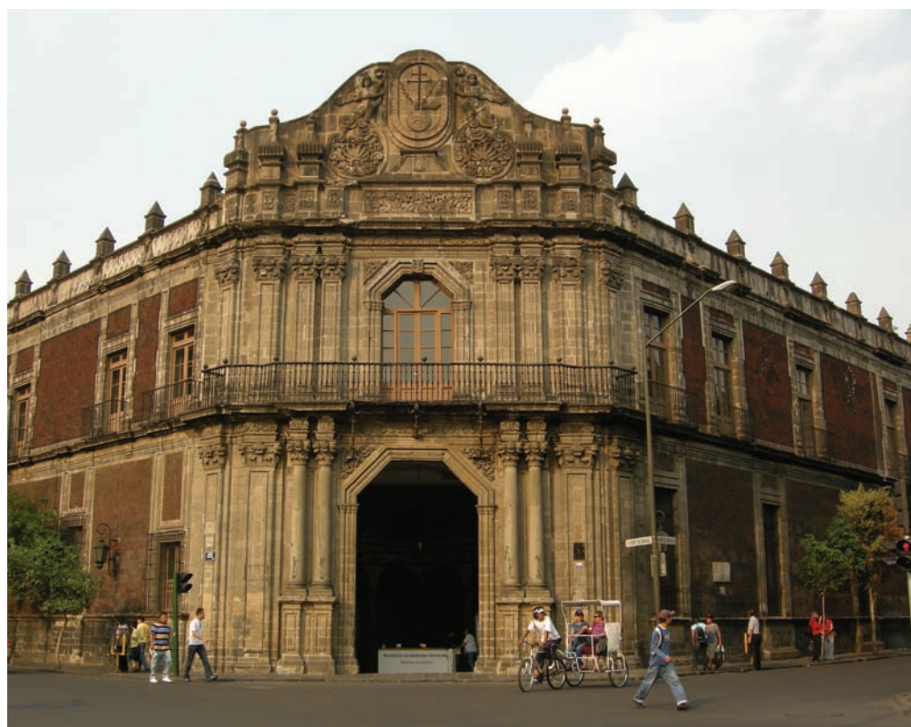
Figura 3. Antiguo Palacio de la Inquisición, hoy Museo de Medicina y Protomedicato de la UNAM. El edificio actual fue construido por el arquitecto Pedro de Arrieta a principios del siglo XVIII. Foto: Martha Fernández.
