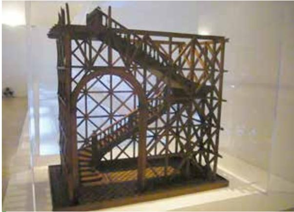
**Figura 1.** Ejemplo de la arquitectura antisísmica del marquês de Pombal. Estructura interna para un edificio.
