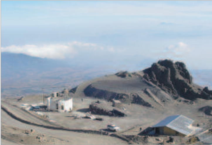
Figura 4. Vista del sitio en el que se está construyendo el radiointerferómetro solar de cinco metros (RT5), a una altura de 4 mil 500 metros sobre el nivel del mar, en el volcán Sierra Negra, en el estado de Puebla.
