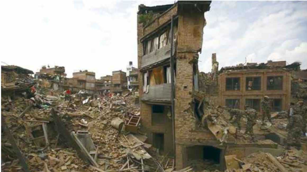
Figura 1. Destrucción causada por el terremoto de magnitud 7.8 en Bhaktapur, Nepal, en 2015 (fotografía: ABC Ciencia y Reuters).
