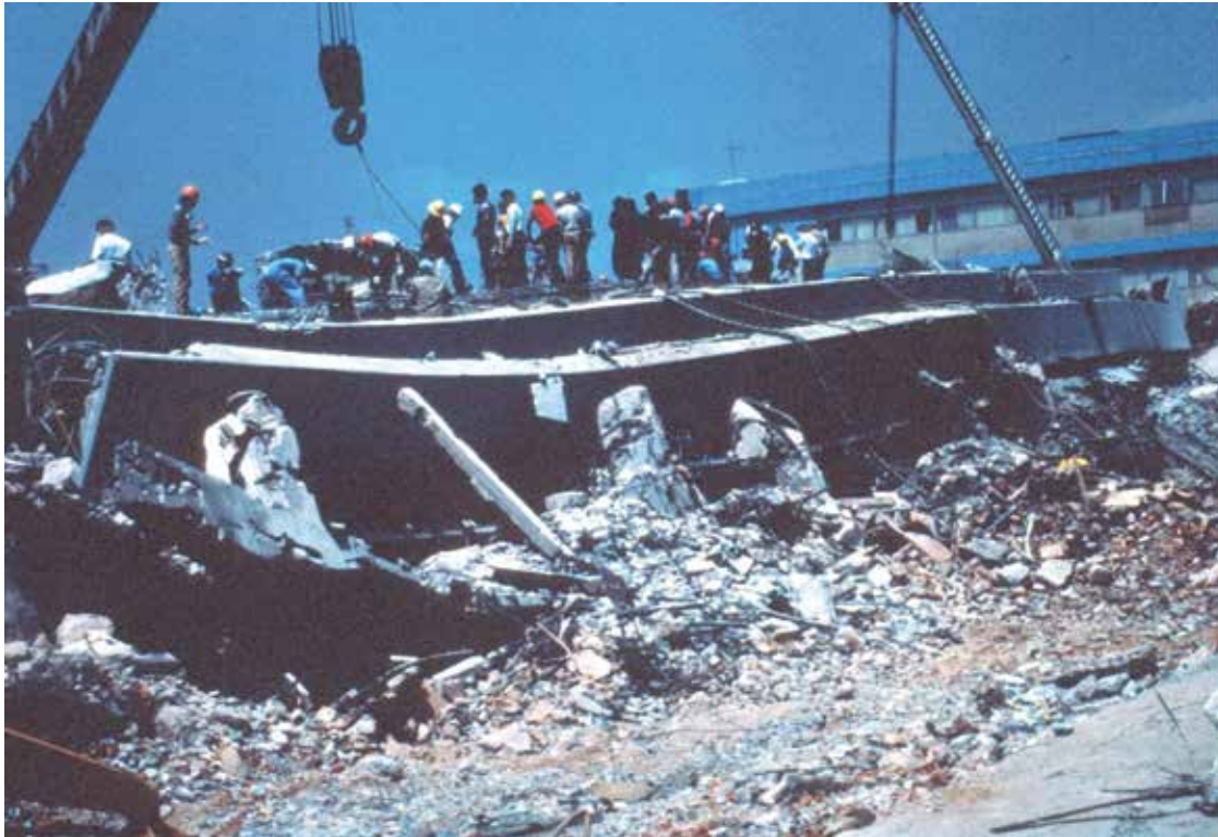
Figura 4. Hospital General colapsado por el terremoto de 1985 (fotografía: USGS, Wikimedia Commons).
