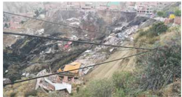
Figura 8. Deslizamiento en Bolivia, 2019 (tomada de: <https://twitter.com/mindefbolivia/status/112333768317722144/photo/2>).
